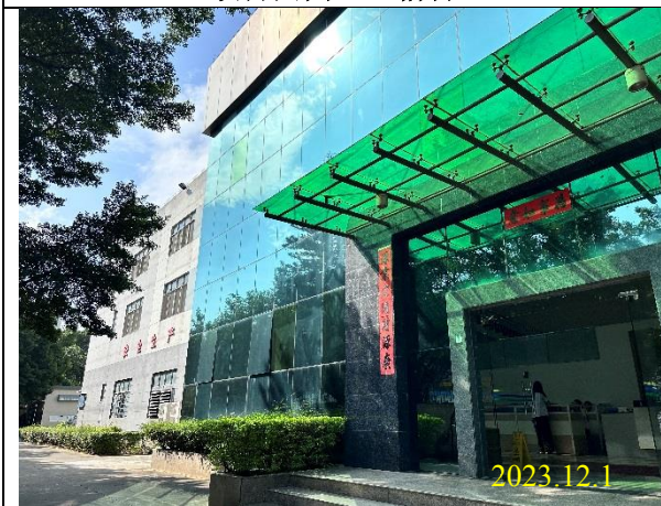
项目厂房建筑物外观
