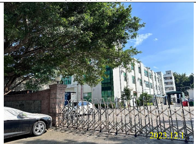
项目东面工业厂房
