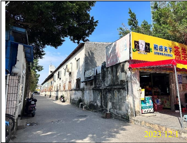
项目北面工业厂房
