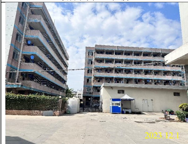
项目西面工业宿舍
